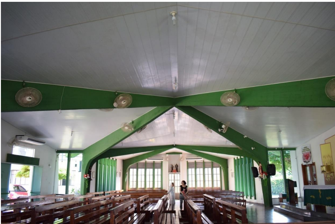
FIGURA 3: Interior da Igreja de Santa Izabel da Hungria.
