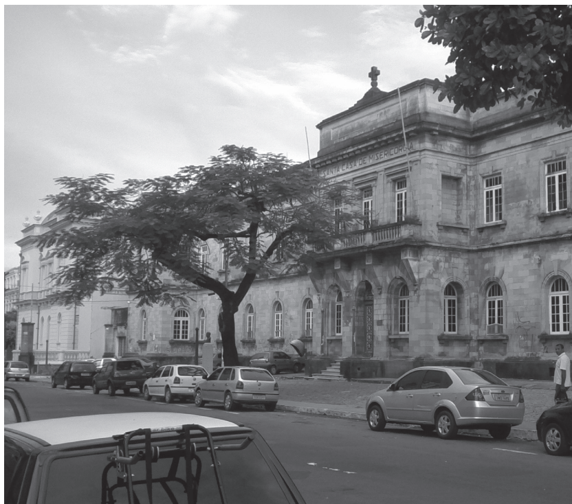
Figura 3: Elevação principal do prédio da Santa Casa de Manaus. Foto: Cybelle Miranda, 2013.
