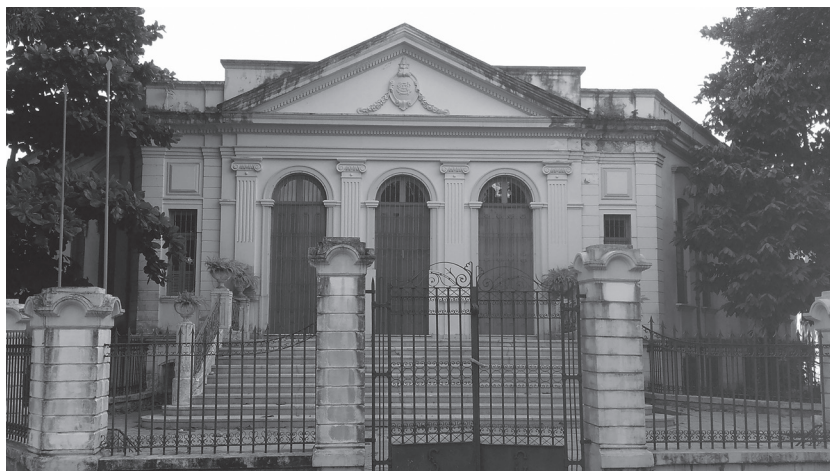
Figura 2: Vista atual da fachada da Santa Casa de Misericórdia do Pará. Foto: Cybelle Miranda, 2017.
