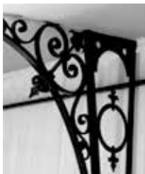
Figura 02: Cantoneira em estrutura metálica comparada com representação românticas.
