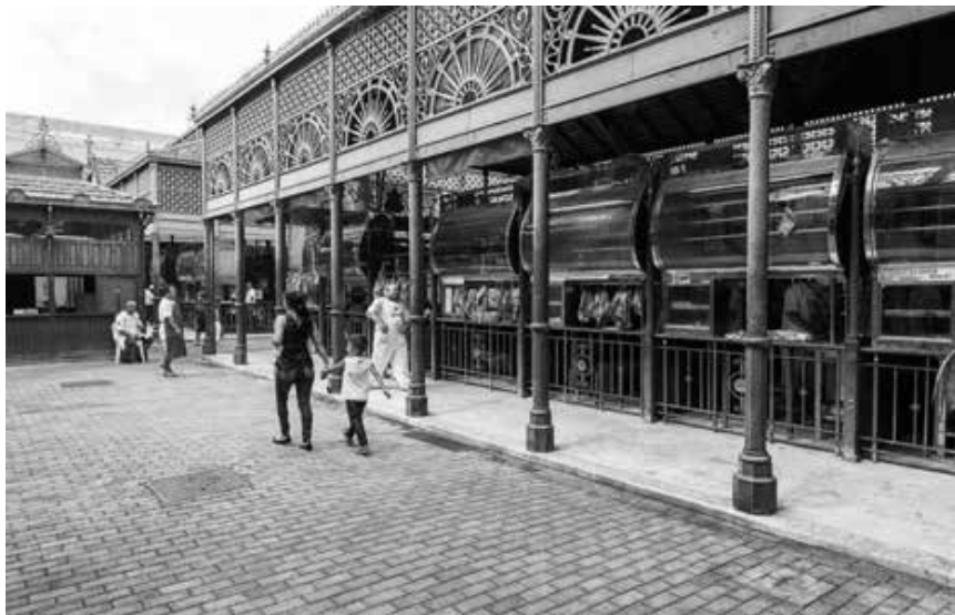
Figura 02: Registro da nova pavimentação e dos frigoríficos suspensos, instalados na intervenção de 2007.
