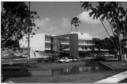
Figura 7. Sede do Departamento de Estradas de Rodagem, 1957-1959, projeto de Camilo Porto de Oliveira.
