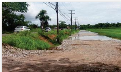
Figura 14. Início do aterro da obra de duplicação da rodovia Duca Serra.
