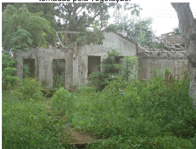
Imagem 10: Ruína de uma casa da Vila Americana, onde restam apenas paredes tomadas pela vegetação.
