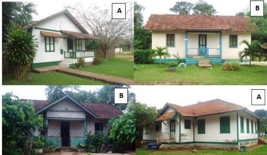
Imagem 10: Bangalôs encontrados em Belterra, sendo: A - em madeira; B – Em bloco cimentício
