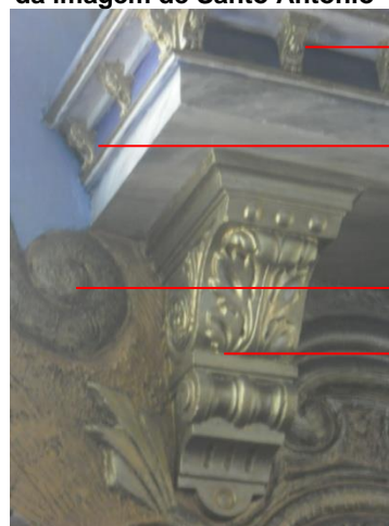
Figura 24: Detalhe da base de sustentação da imagem de Santo Antônio
