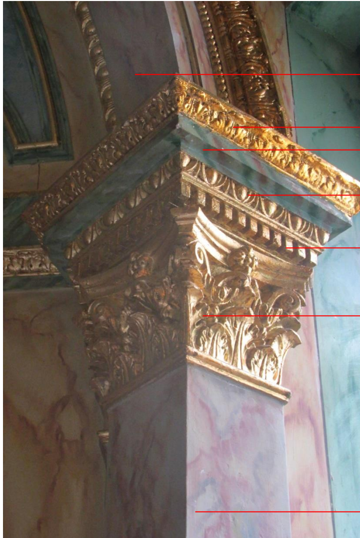
Figura 6: Detalhe da coluna da capela do altar mor
