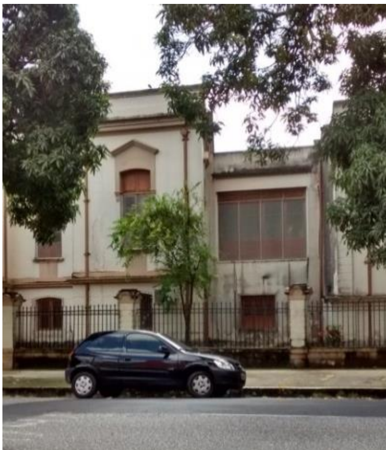
Imagem 63: Jogo de janelas demonstrando as alterações ocorridas no edifício.
