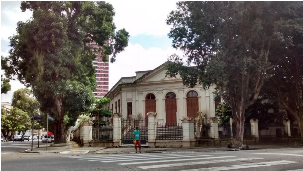
Imagem 62: Entrada da nova capela do Hospital da Santa Casa de Misericórdia
