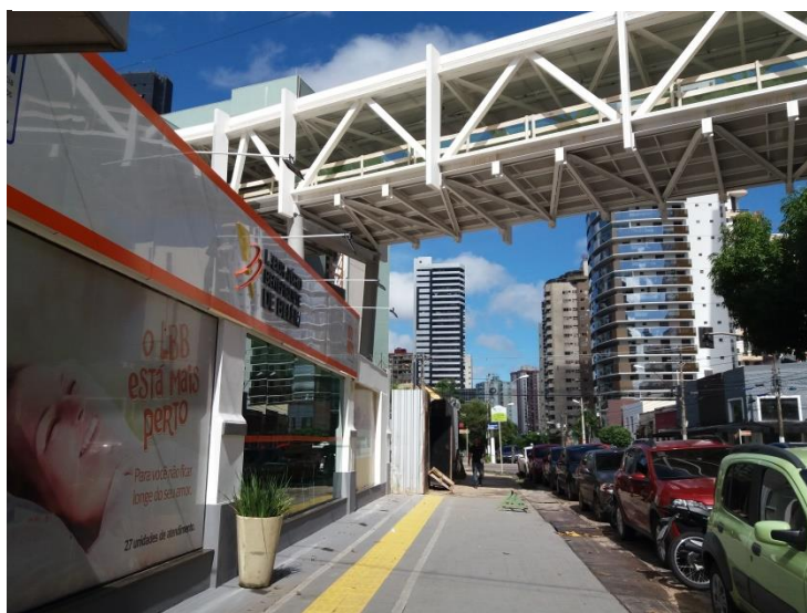
Figura 55: Passarela na Rua Boaventura da Silva
