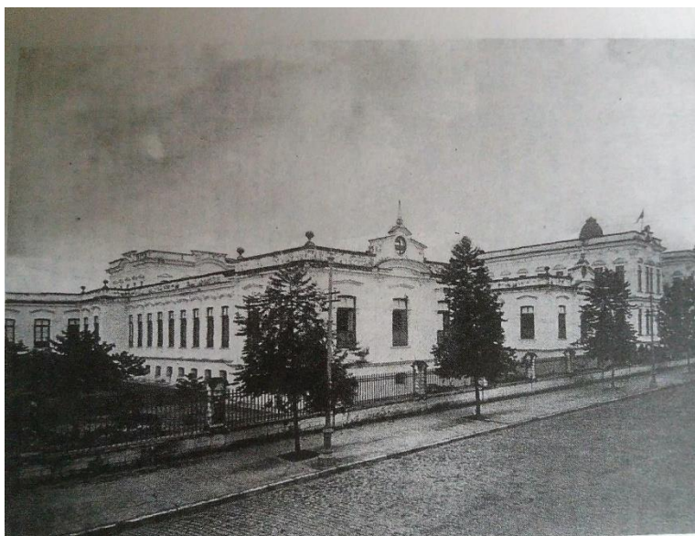
Figura 71: Ala Direita do Hospital da Caridade, vista da Rua Oliveira Belo.
