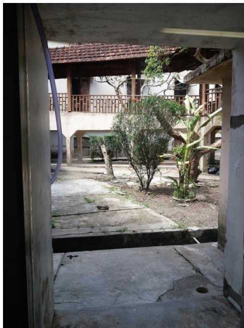
Figura 69: Vista da janela do porão no bloco da pediatria, onde vê a passarela.
