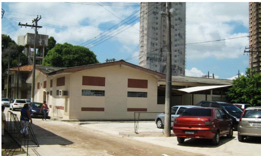
Figura 21: Prédio da lavanderia demolido para dar lugar ao prédio da maternidade. Ao fundo o bloco da dermatologia.
