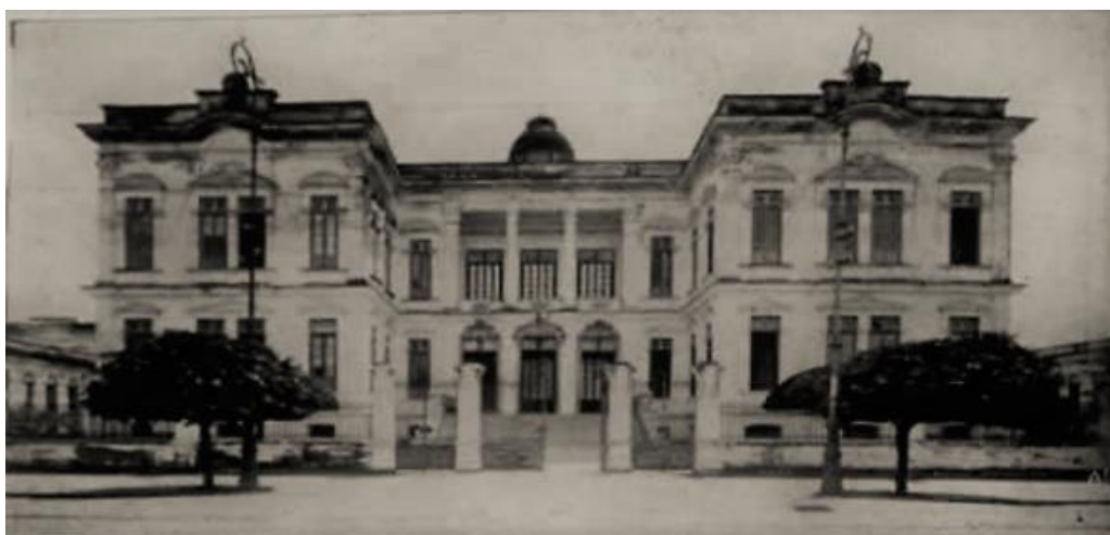
Figura 3: Hospital da Caridade, entrada Principal pela Rua Oliveira Belo.
