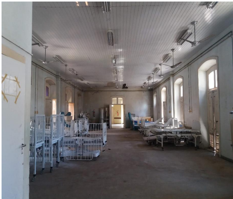
Figura 63: Espaço reservado no projeto de reforma, para a instalação de um novo museu. Antiga enfermaria do prédio da maternidade, construído em 1914.
