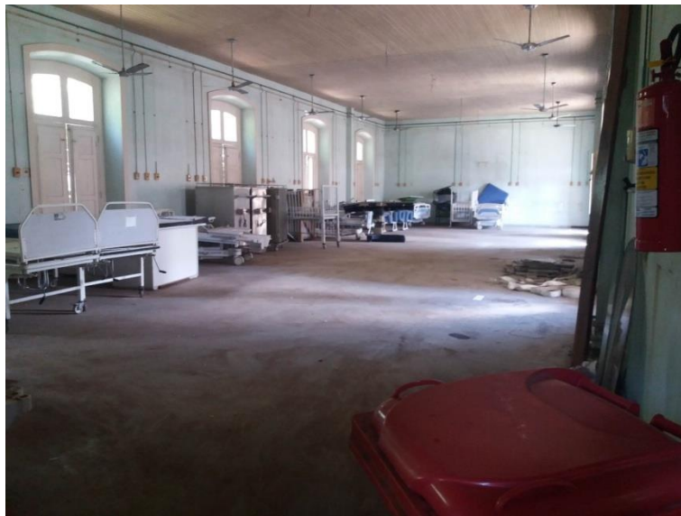
Figura 67: Enfermaria que antes servia à maternidade terá novo uso.
