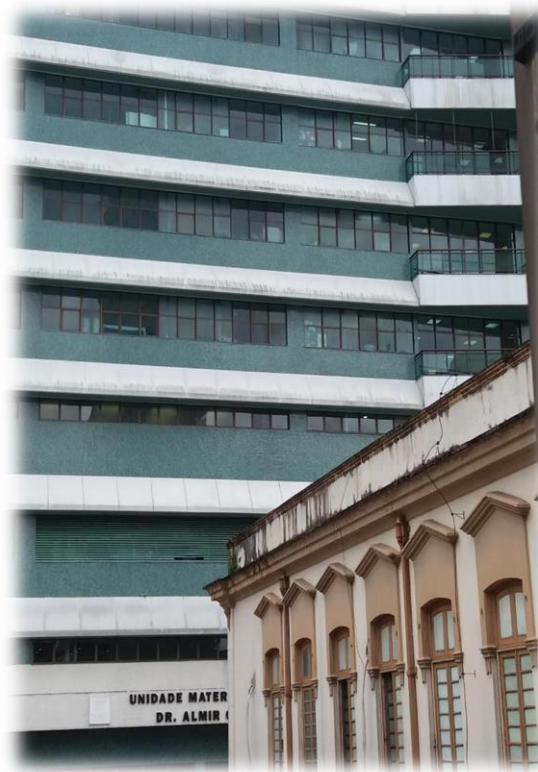
Figura 14: Vista Interna do Complexo, feita de uma janela do corredor principal de ligação dos blocos Centenários. Em primeiro plano um dos blocos centenários e ao fundo o prédio da Nova Maternidade.
