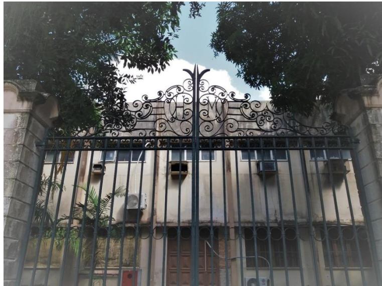
Figura 119: Detalhe do gradil da entrada solene do Hospital da Caridade de 1900.
