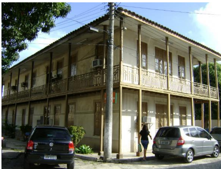
Figura 16: Bloco de dermatologia demolido em 2010.
