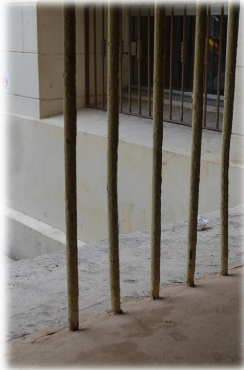
Figura 31: Vista das esquadrias dos porões a partir do porão do corredor principal, com o bloco 35 ao fundo, onde hoje funciona o setor de infraestrutura.
