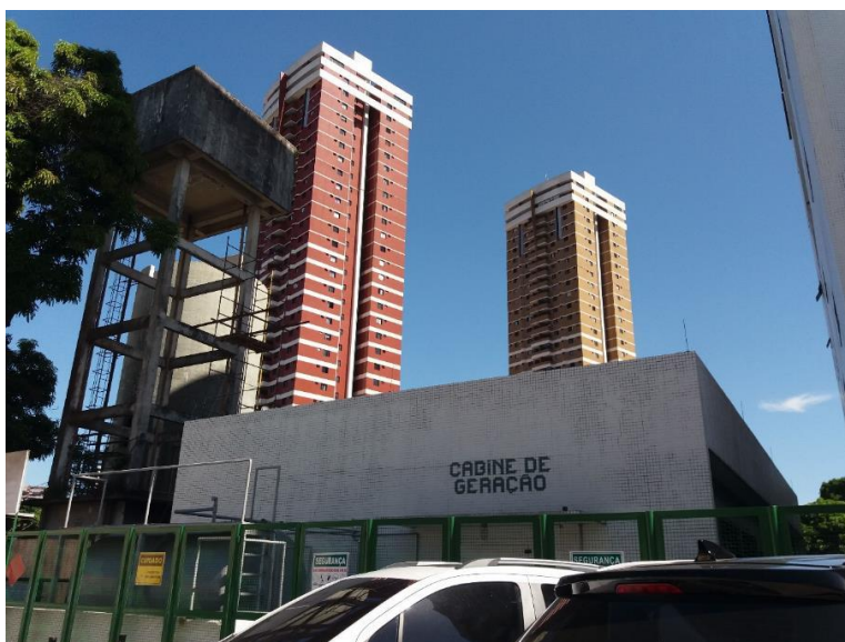
Figura 22: Edificação construída no local do antigo prédio da Dermatologia.
