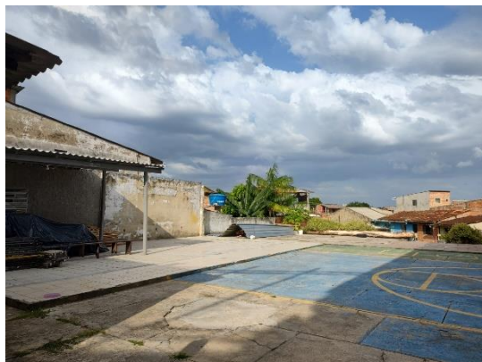
Figura 3. Área da escola da Igreja Luterana pós-demolição – Fonte: Paula Flores, 2022.
