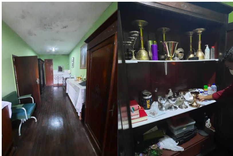
Figuras 17 e 18. Área da Sacristia e armário de armazenamento de itens de celebração. Fonte: Raissa Souza, 2022.
