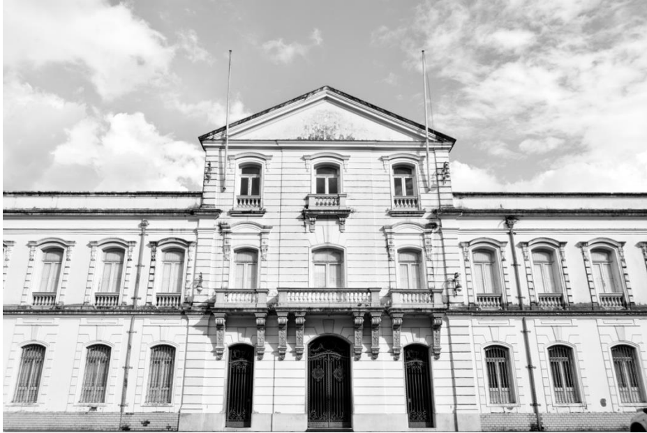
Figura 2: Fachada Principal do Palácio de Landi, atual Museu do Estado do Pará. Fonte: Vithória Silva, 2018
