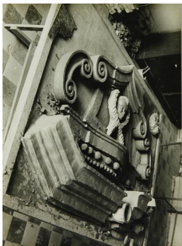
Figura 16: Detalhes da modelagem em barro da parte superior do altar da capela para pesquisas de forma e dimensão. Fonte: Acervo IPHAN, 1972
