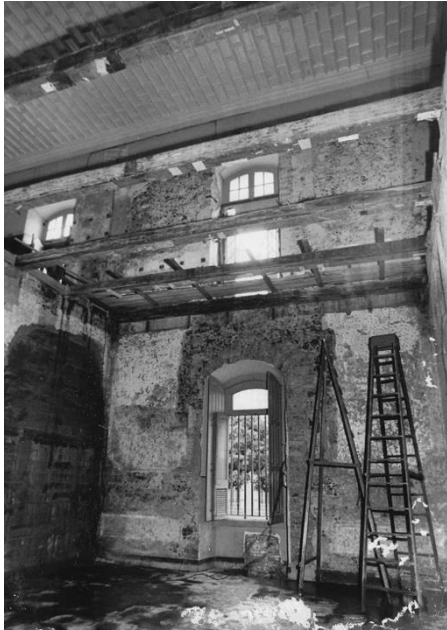
Figura 13: Vista da parede de entrada da capela, já com prospecções, onde aparecem os quadros de moldura confirmando sua existência.
