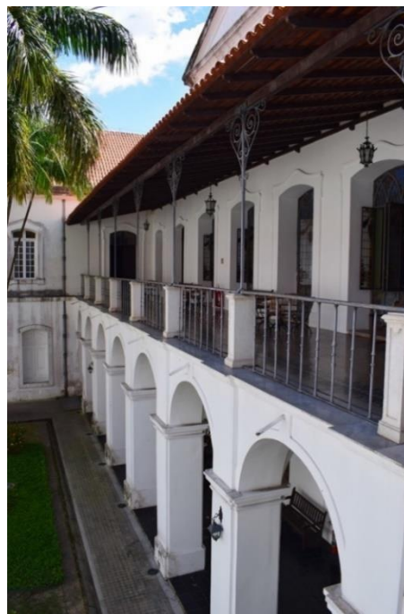
Figura 7: fotografia tirada do corredor em seu estado atual no Palácio de Landi, após o restauro operado por La Rocque. Fonte: Vithória Silva, 2018
