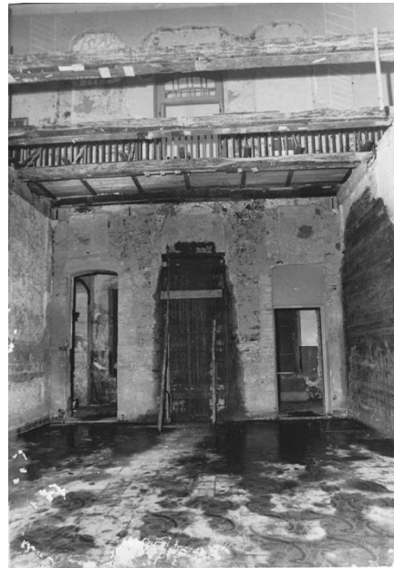
Figura 14: Visão geral da área da capela mostrando o piso de madeira que dividia o seu duplo pé direito já em demolição, e o revestimento do piso térreo em mosaico, antes da pesquisa arqueológica.
