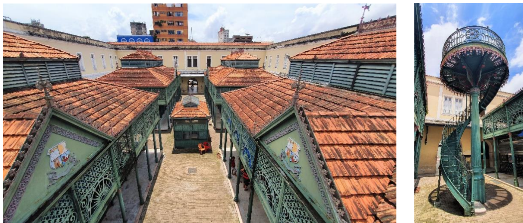
Figuras 31 e 32: Mercado de carne de 1908, localizado na zona de comércio no Ver-o-Peso e detalhe da escada em ferro no hall central do mercado, onde originalmente, sustentava um reservatório de água.
