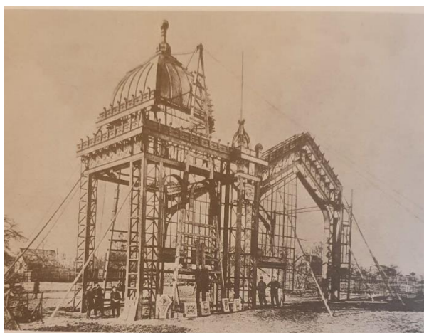
Figura 12: Pré-montagem do orfanato antes de seu envio para Belém.
