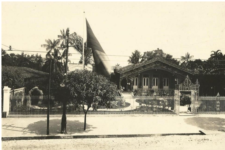
Figura 70: Fachada principal da residência de Antonio José de Lemos.
