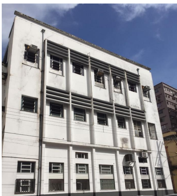
Figura 49- Fachada do Hospital de 2022.
