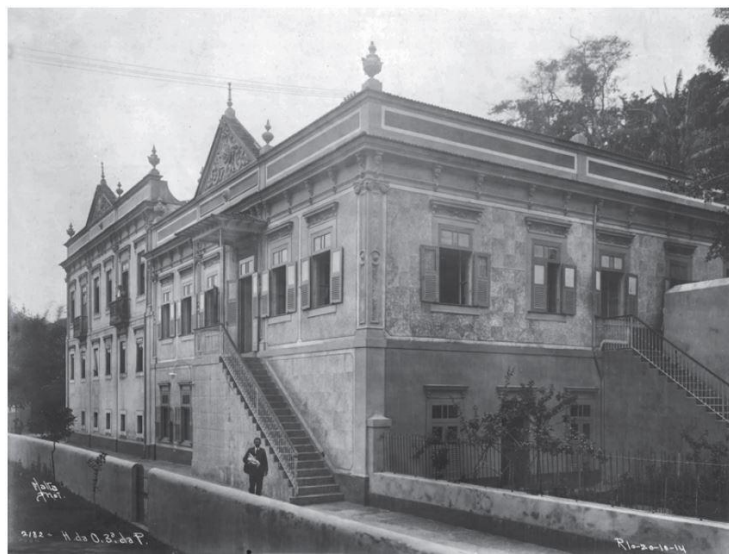
Figura 6- Novo Hospital da Ordem Terceira de São Francisco da Penitência, Rio de Janeiro
