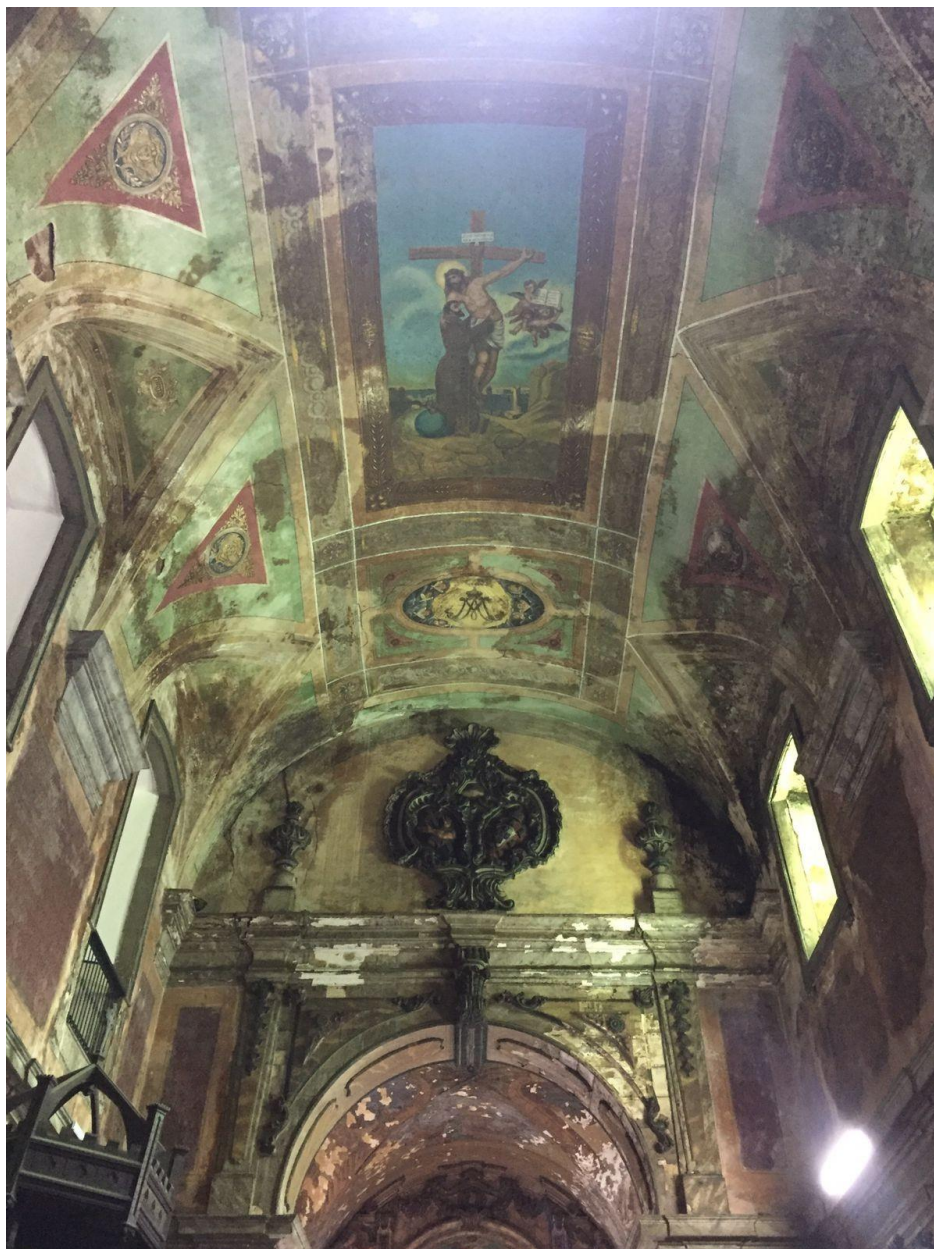
Figura 38- Forro da nave.
