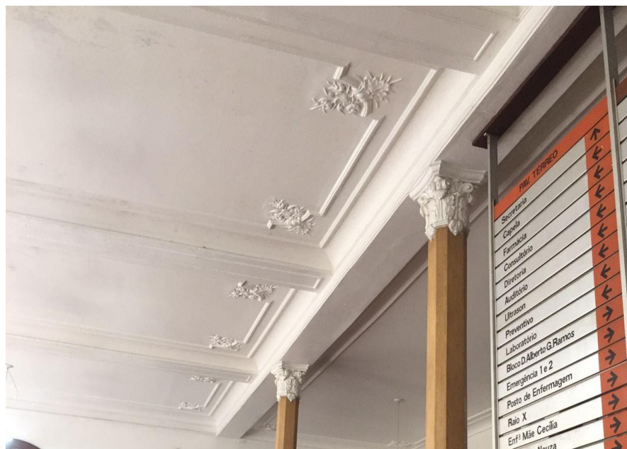
Figura 61- Forro hall de entrada.
