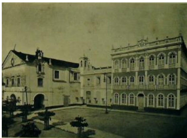
Figura 11- Fachada Classicista do Hospital
