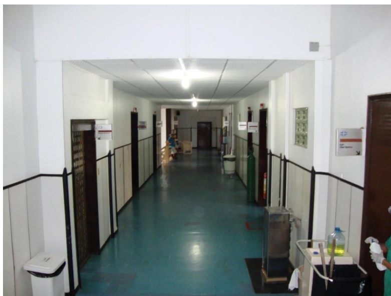
Figura 74- Piso e forro segundo andar.
