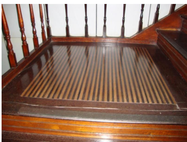
Figura 70- Patamar de madeira.
