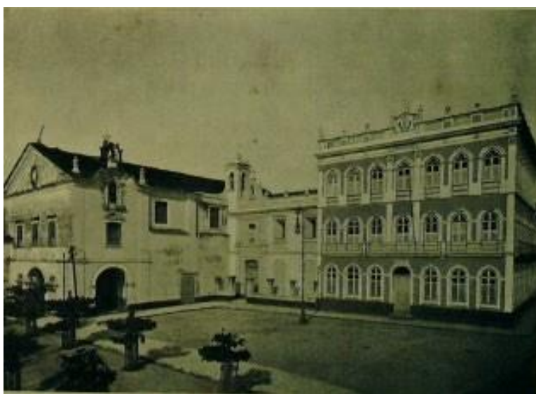
Figura 48- Fachada do Hospital de 1987
