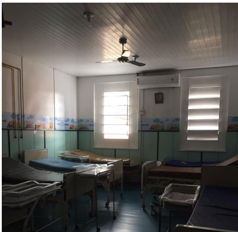
Figura 77- Forro de PVC enfermarias
