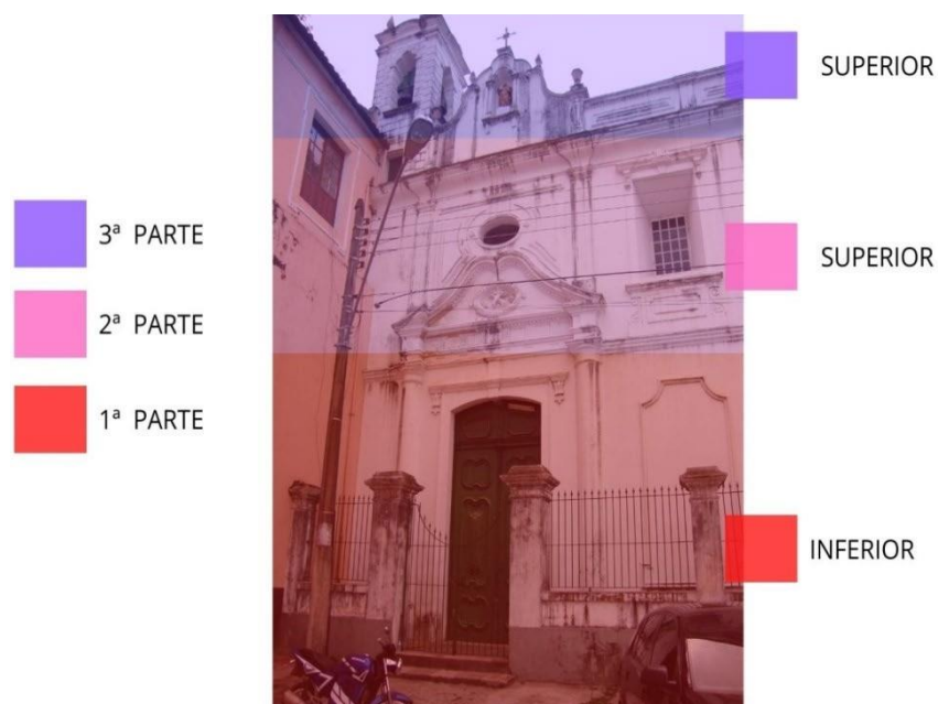
Figura 21- Decomposição de partes da fachada da Capela.
