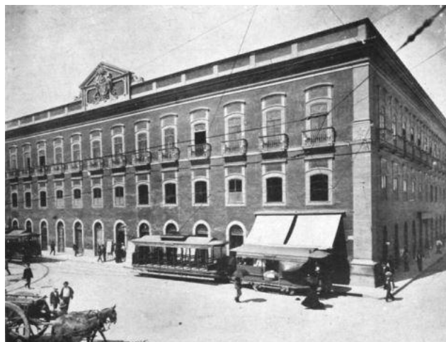
Figura 5- Hospital da Ordem Terceira de São Francisco da Penitência, Rio de Janeiro.
