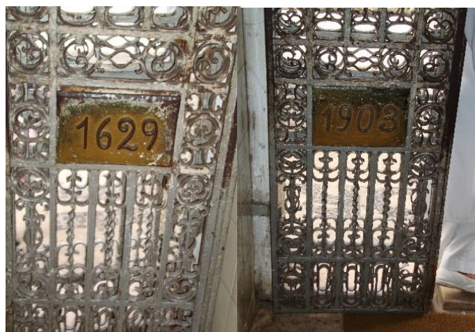
Figura 52- Detalhe em vermelho do portão.
