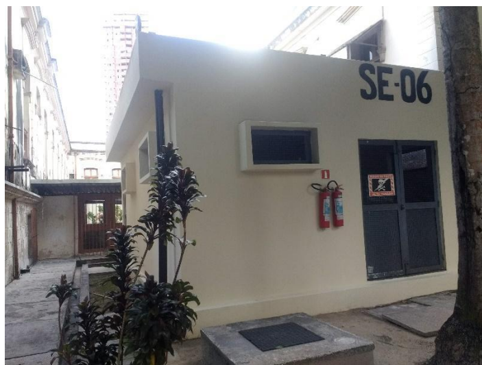
Figura 62 - Pequena construção localizada entre pavilhões, possivelmente casa de máquinas.
