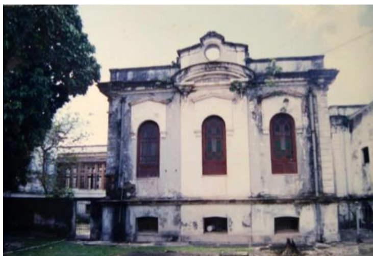
Figura 27 - Fachada principal da capela, com frente voltada a Avenida Generalíssimo Deodoro.
