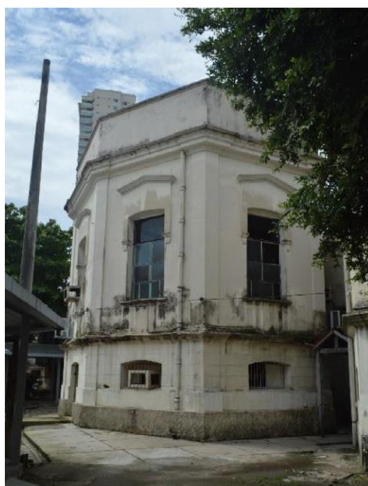
Figura 55 - Vista externa do pavilhão.
