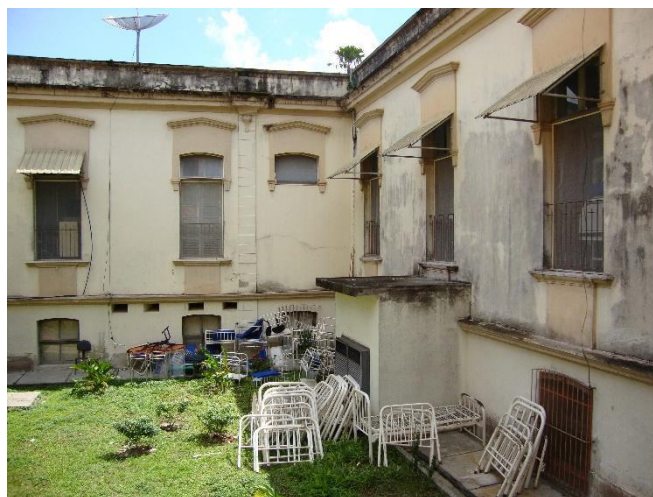
Figura 44 - Vista das janelas do pátio interno
