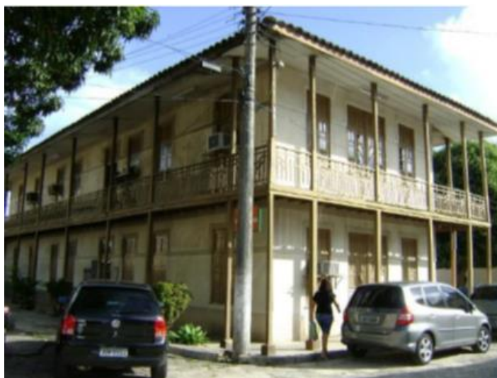
Figura 37 - Bloco de Dermatologia.
