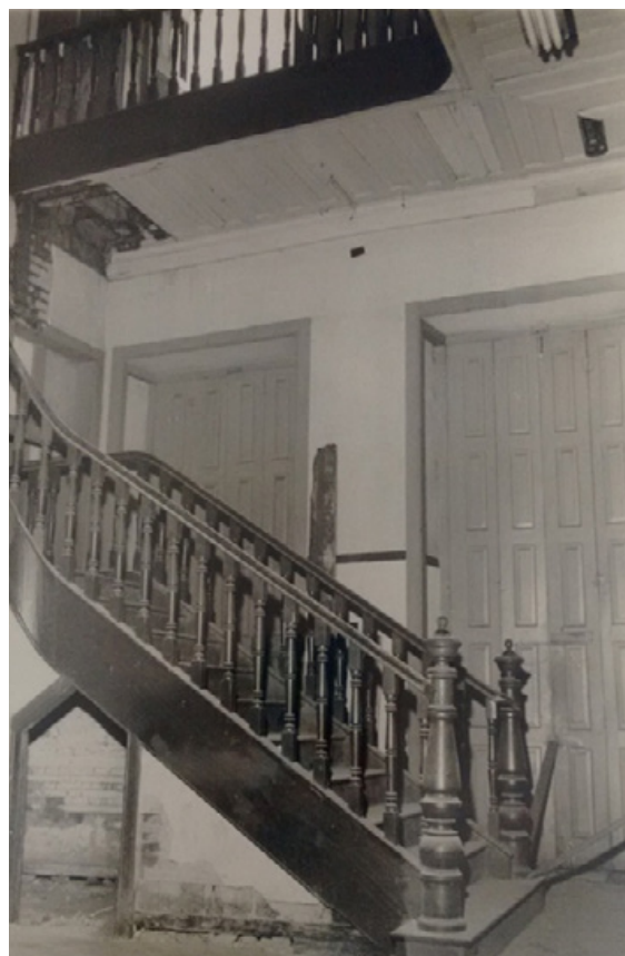
Figura 14 – Escada antes da reforma de 1974. Fonte: Acervo da Biblioteca da CODEM, [197-?].
