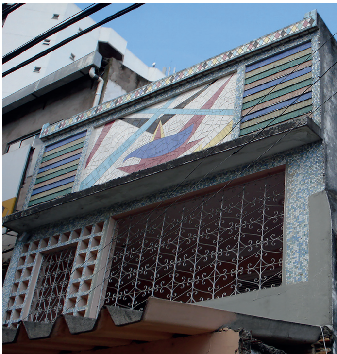
Figura 1.5 Fachada RQP desaparecida, no bairro de Batista Campos.
