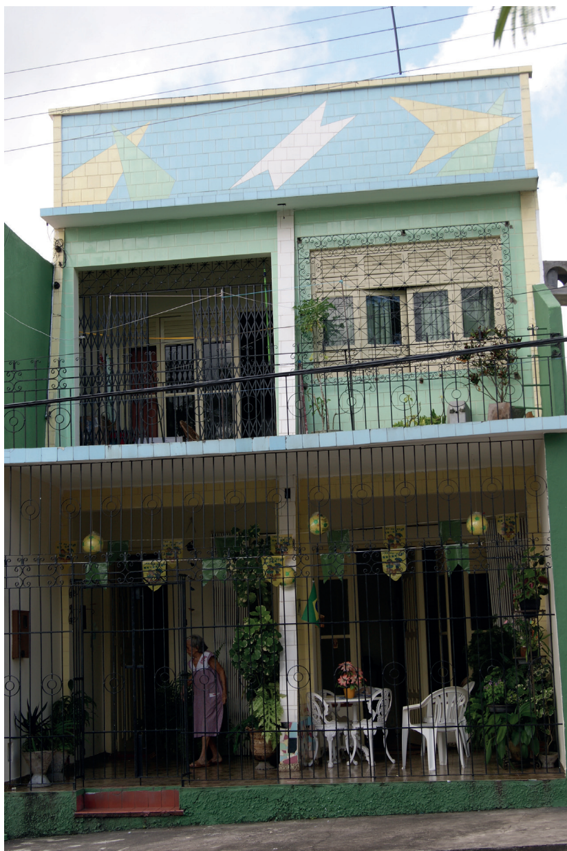
Figura 1.10 Casa em Bragança, já demolida.
