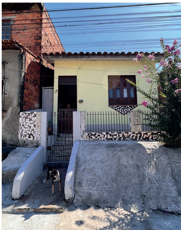
Figura 2.3 Residência RQP feita em barro (“casa de enchimento”) e alvenaria de tijolo.
