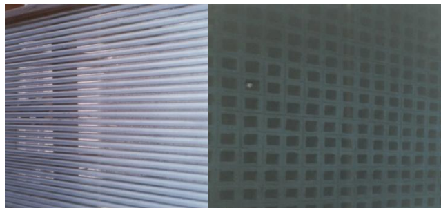
Figura 2.19: E os materiais mais industrializados poderão ser dispostos nas divisões internas tais como tubos e cobogós Fotos do autor, 2003.
