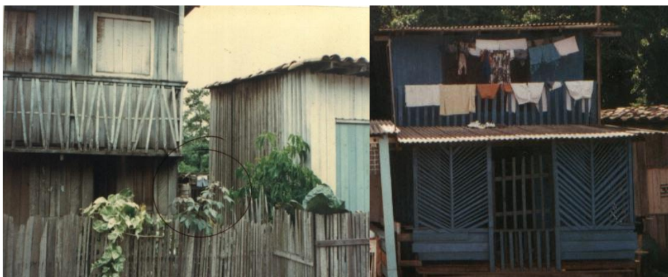
Figura 2.20: A madeira em forma de ripa, compondo fachadas, balcões e cercas. Fotos do autor, 1996.
