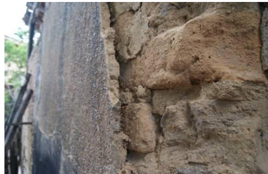
Figura 2.6: Detalhe da parede em taipa de mão, tabique.
